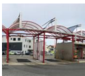
Autowaschanlage, 42m 2 , 60°C Forel
